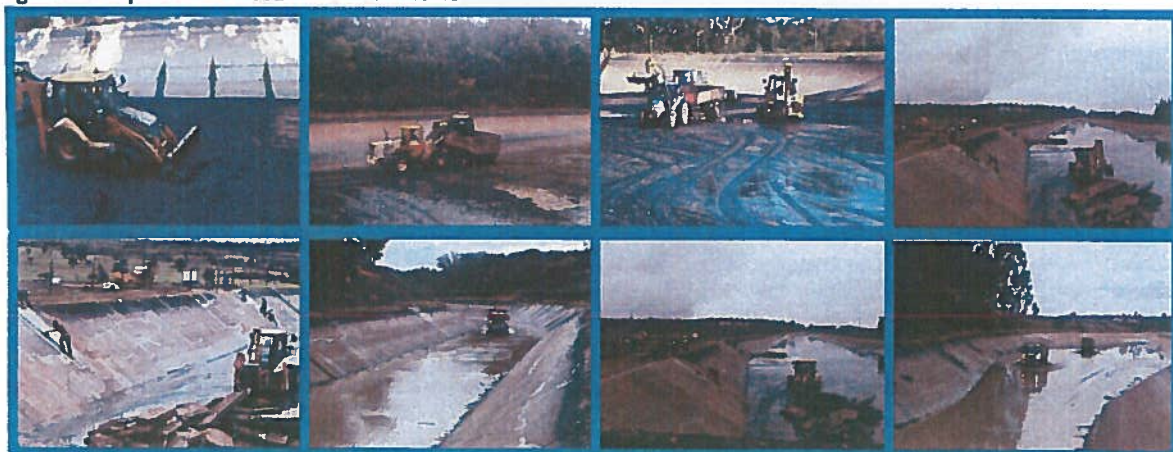
Figura 7: Limpeza do reservatório de Odeceixe
