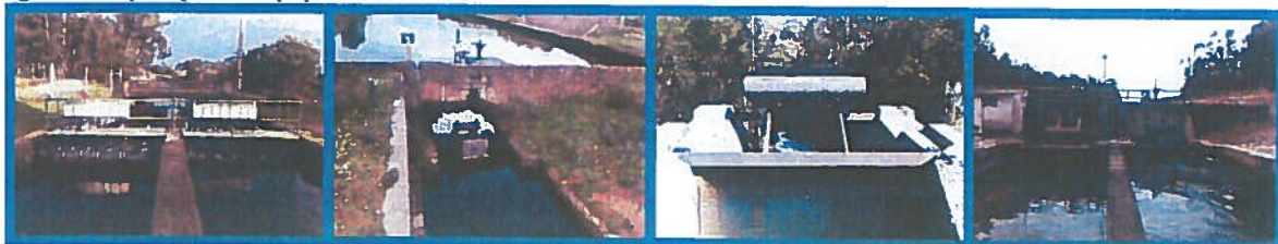
Figura 5: Reparação de equipamento hidromecânico
