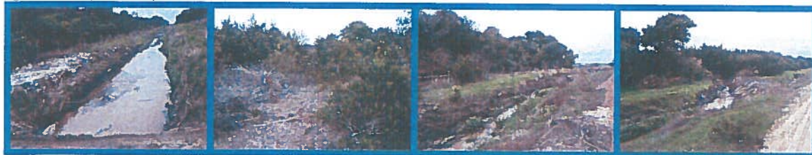
Figura 4: Limpeza e reperfilamento do Coletor dos Nascedios
