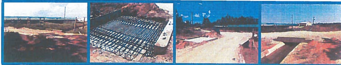
Figura 6: Reconstrução com alargamento de pontão sobre o Distribuidor da Azenha
