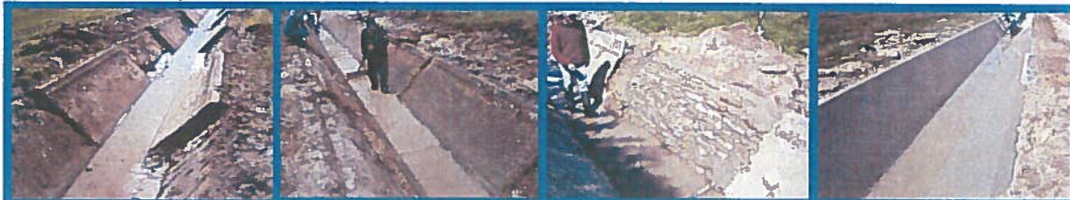
Figura 4: Reconstrução do Distribuidor das Courelas
