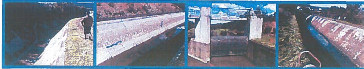
Figura 3: Manutenção do Canal Condutor Geral
