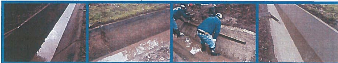
Figura 3: Reconstrução do Distribuidor do Samouqueiro
