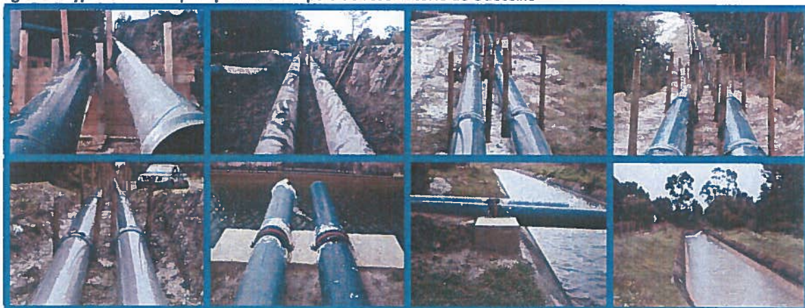
Figura 6: Bypass efetuado para permitir a limpeza do reservatório de Odeceixe
