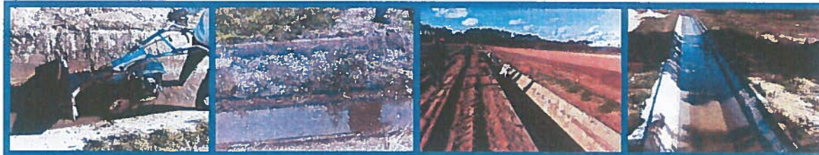
Figura 2: Reconstrução Total do Distribuidor dos Portos Ruivos
