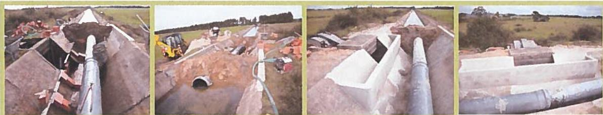
**Sifão de Telhares:** Reparação de roturas no sifão de telhares com execução de reforço em betão armado, alternando-se o trabalho nas três linhas que compõem o sifão, para que não fosse afectado o fornecimento de água aos regantes.
