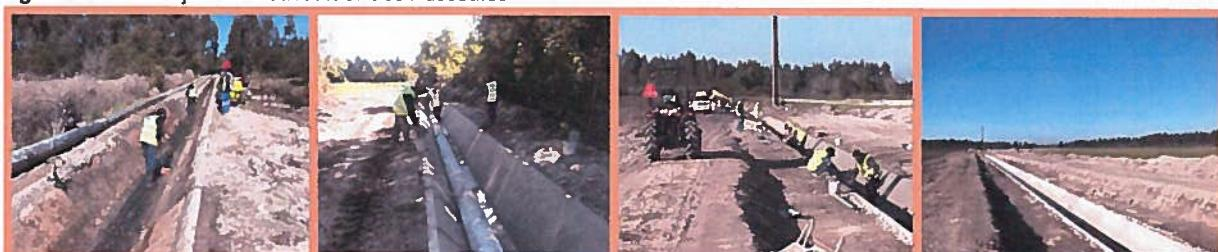
**Reparação dos tirantes do Canal Condutor Geral:** Durante o ano de 2018 deu-se início aos trabalhos de reabilitação dos tirantes com a aplicação de um primário de aderência e revestimento anticorrosivo nas armaduras que já se encontravam à vista, e posterior reconstrução de cada tirante de argamassa de reabilitação estrutural.
